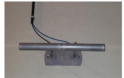
Staurohr auf gegenüberliegender Seite und pneumatische Verbindung zur Anschlussbox
